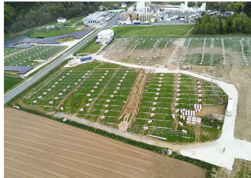
Oben links: Die neue Freiflächen-PV-Anlage liegt direkt neben dem Werk. Oben rechts: Insgesamt werden 16.000 Solarmodule verbaut.
